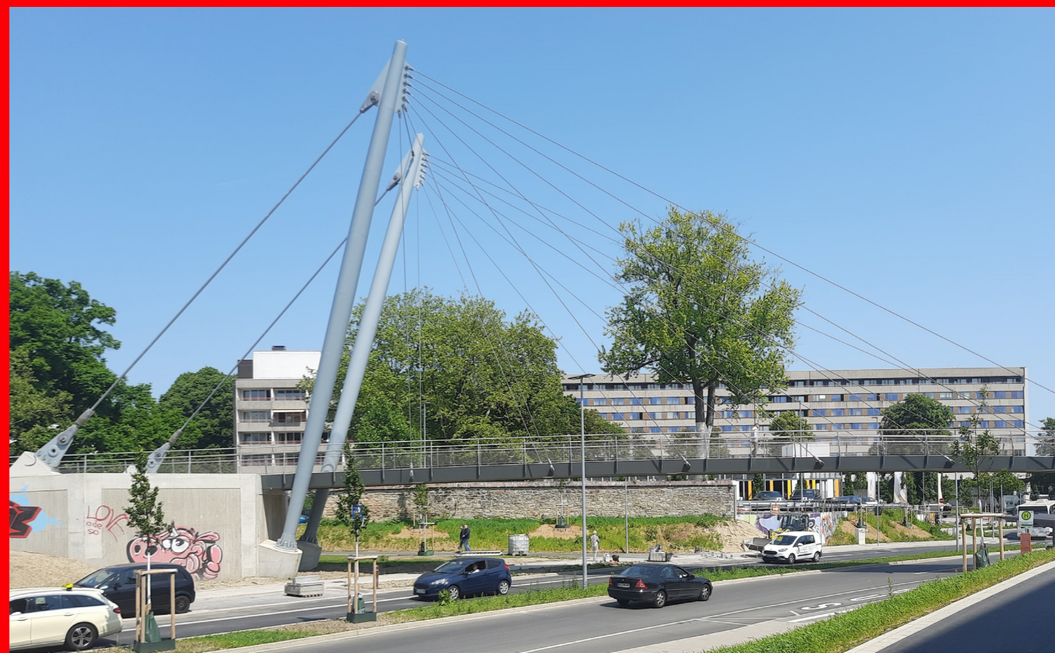
Foto: Die neue Brücke an der Pferdebachstrasse
